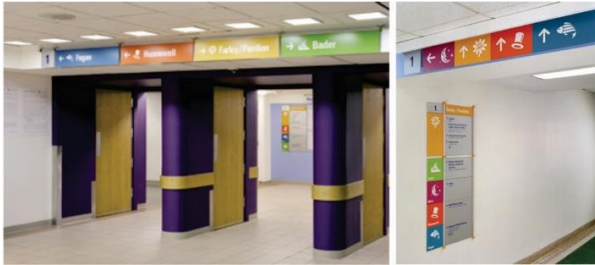
Figura 5 – Sinalização – placas direcionais (acesso aos elevadores e circulações)
