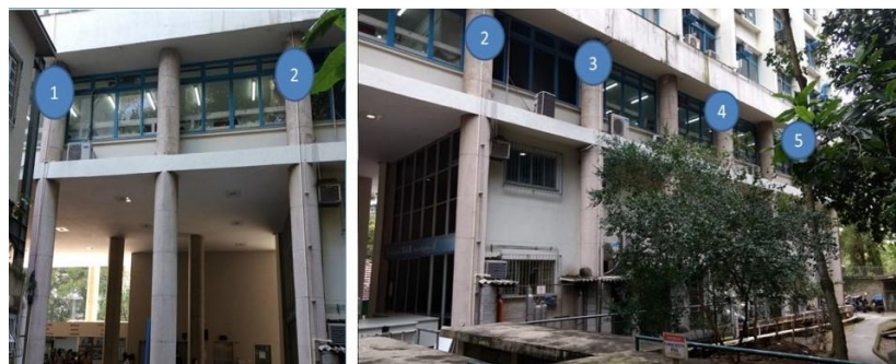
Fig. 2 - Tubulação de água condensada no Bloco E. Fonte: fotos do autor.
