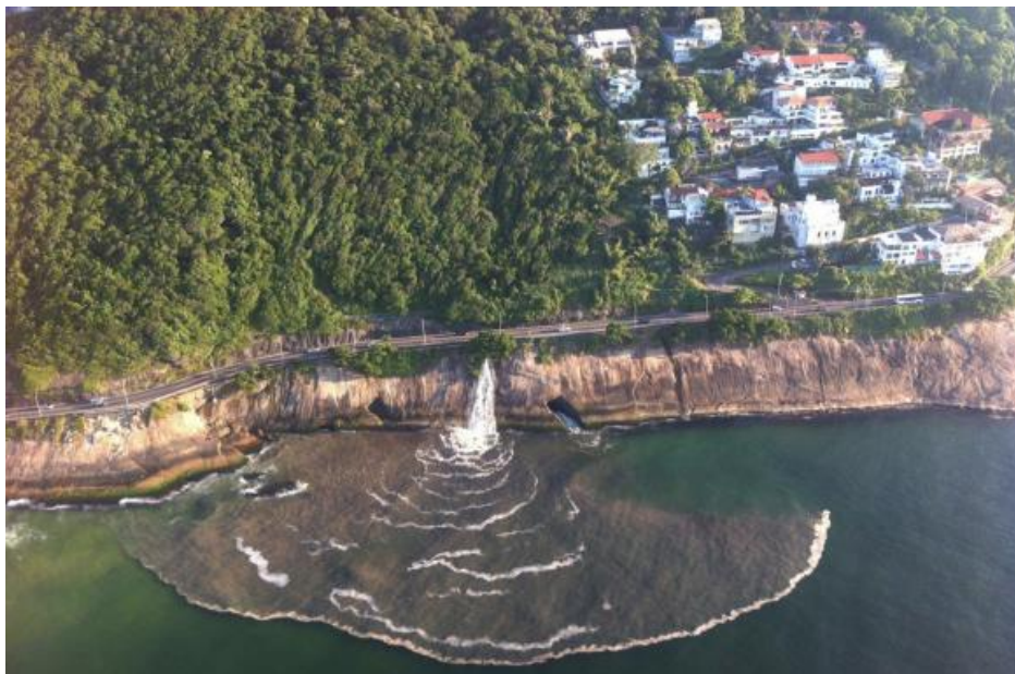
Figura 2: Esgoto in natura sendo despejado no costão localizado ao longo da Avenida Niemeyer. Fonte: Rádio CBN/Thiago Mathias (2014).
