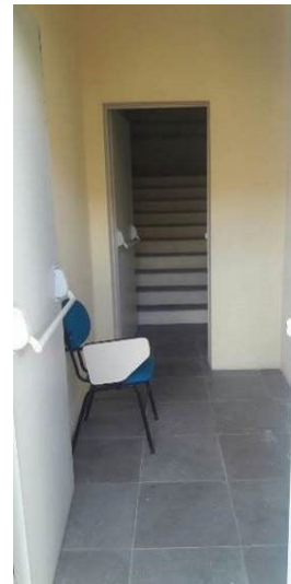
Figura 04 – Entrada da saída de emergência do prédio Cotada Fonte: Autor (2018).
