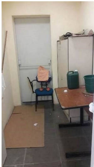
Figura 06 – Saída de Emergência utilizada como vestiário Fonte: Autor (2018).
