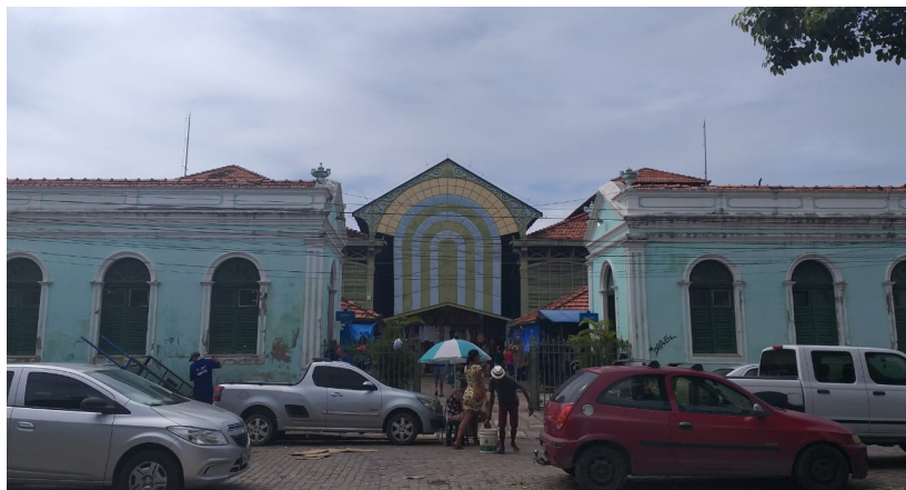
Figura 1. Entrada Principal do Mercado de São José. Fonte: Autores.
