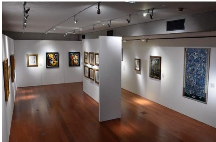
Figura 3 - Sistema de iluminação permanente da galeria Millennium
