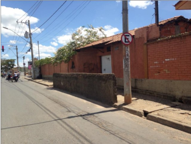
Figura 2. A entrada de uma escola pública fundamental onde uma parede em frente à porta de saída separa o passeio da via.
