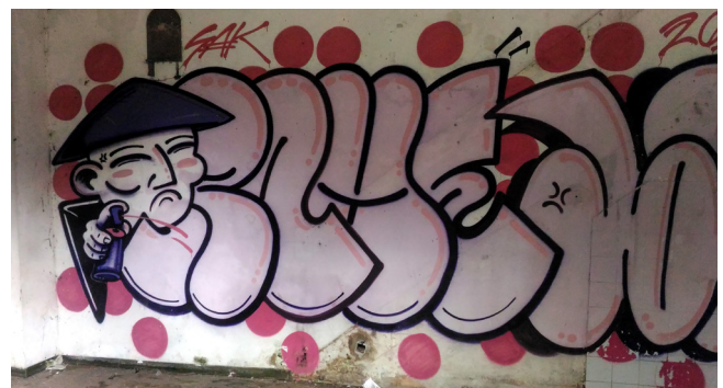
Figura 3: Pintura nas paredes internas da casa abandonada.
