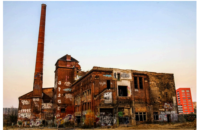
Figura 11: Panorama do prédio abandonado da Eisfabrik.
