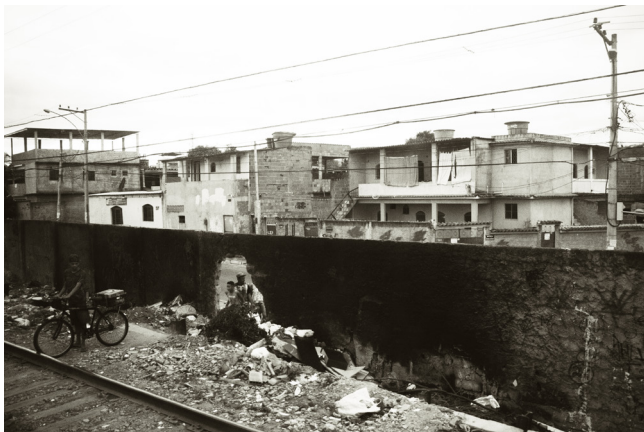
Figura 1. Furo de passagem no ramal ferroviário Santa Cruz, Rio de Janeiro.
