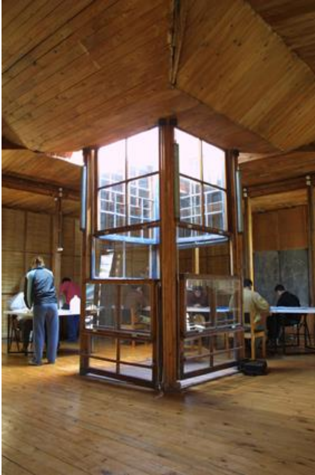
Obra na Cidade Aberta. Claraboia da sala da música. Cidade Aberta. Arquivo fotográfico José Vial Amstrong. Escola de Arquitetura e Design, PUC-Valparaíso.
