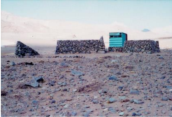
Obra de travessia em Curimahuida. Arquivo fotográfico José Vial Amstrong. Escola de Arquitetura e Design, PUC-Valparaíso.
