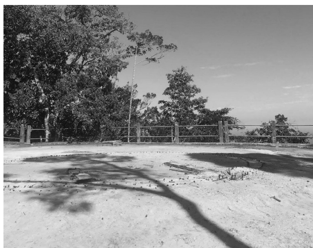
Figura 9. Vazio deixado após o processo de arruinamento da torre, 2019.
