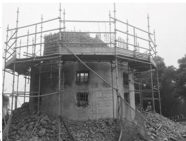
Figura 7. Demolição do corpo da torre durante o processo de arruinamento, 2016.
