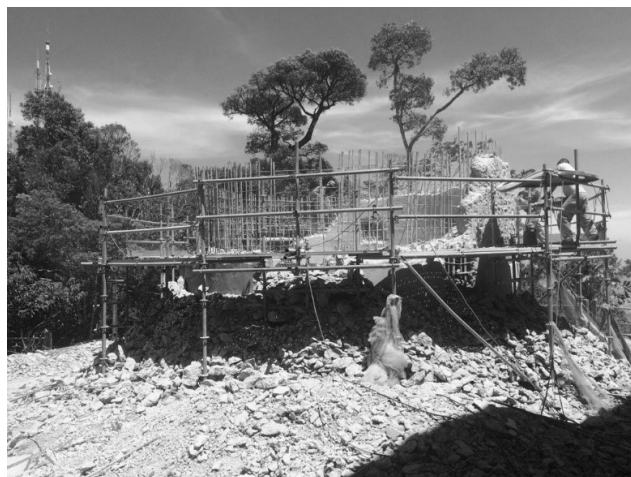
Figura 8. Demolição da base durante o processo de arruinamento da torre, 2016.
