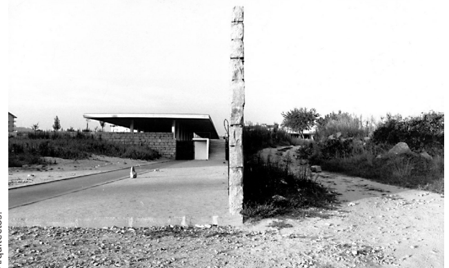
Figura 5. Eixo longitudinal, acesso noroeste. Muro de blocos de granito em junta seca.
