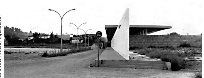
Figura 4. Eixo longitudinal, acesso nordeste. Muro de concreto pintado de branco.
