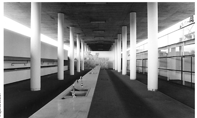
Figura 6. Eixo transversal. Muro em bloco de granito com junta seca e área destinada ao comércio.
