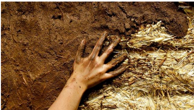
Trabalhos de reconstrução nos morros de Valparaíso utilizando pallets, palha e barro. Divulgação Grupo MADE
