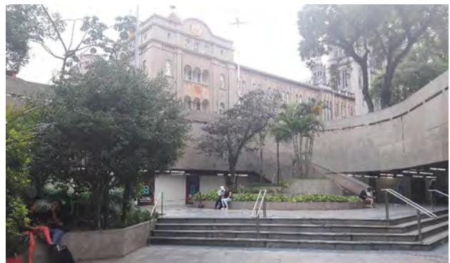
Figura 15: Acesso à estação São Bento.
