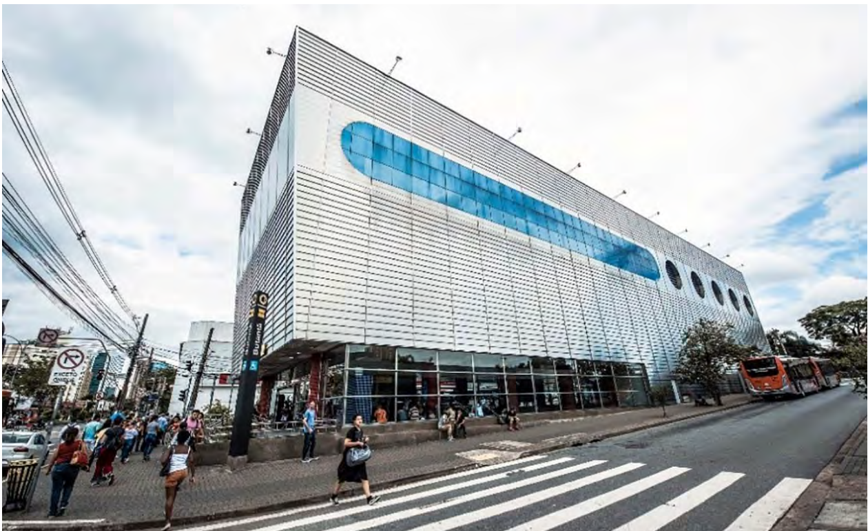
Figura 19: Estação Butantã, na linha 4-Amarela.
