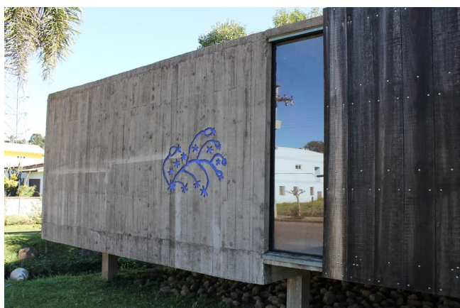
Figuras 7 e 8: Emprego do concreto armado nas fachadas.
