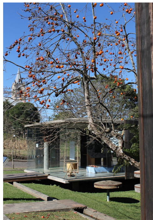
Figuras 9 e 10: Emprego do concreto armado nas fachadas.
