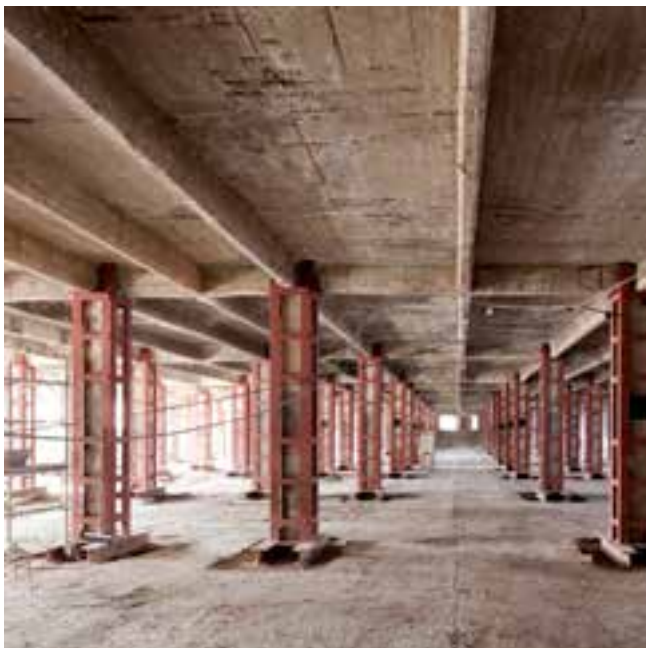
Figuras 13: Reforço estrutural nos pavilhões 8 e 9.
