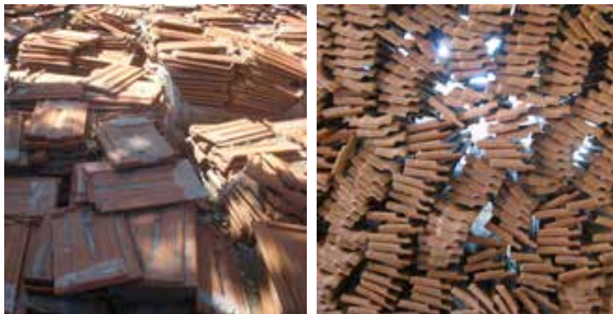
Figura 8: Armazenamento das telhas planas retiradas das coberturas dos galpões do Matadero Madrid; esquema conceitual da reutilização destas telhas na intervenção do Pavilhão 8b.
