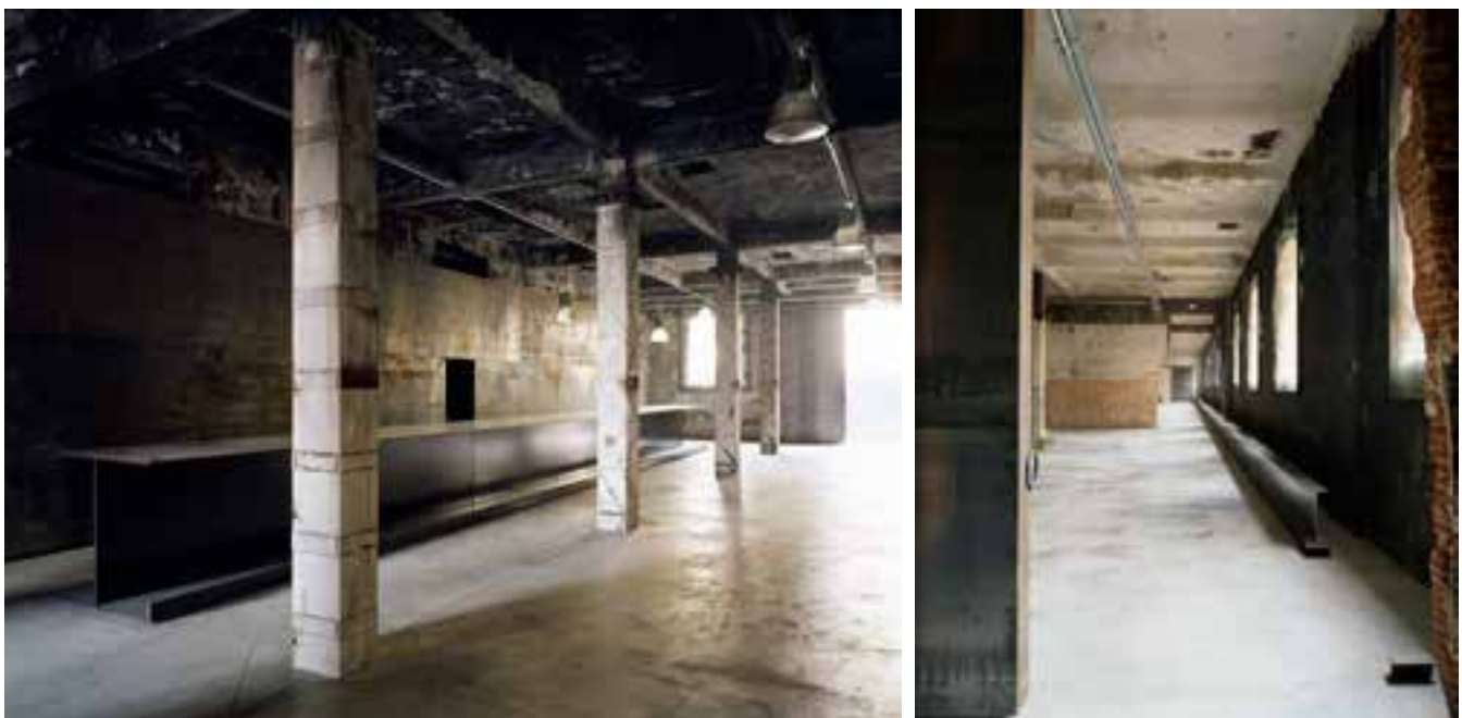
Figuras 15: Perfis metálicos HEB-1000 e IPE-600 na forma de mostrador e banco corrido; piso contínuo de concreto armado no vestíbulo do Pavilhão 17c - Intermediae.
