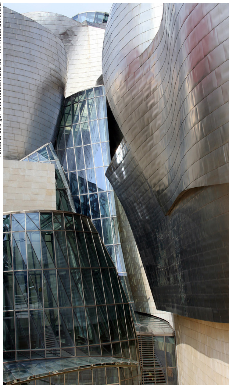
Museu Guggenheim de Bilbao - Frank Gehry 1991 - 1994
