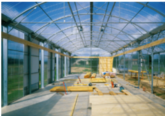
Montagem da Casa Coutras.
