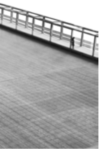
o na cobertura dos pavilhões 8 e 9.
