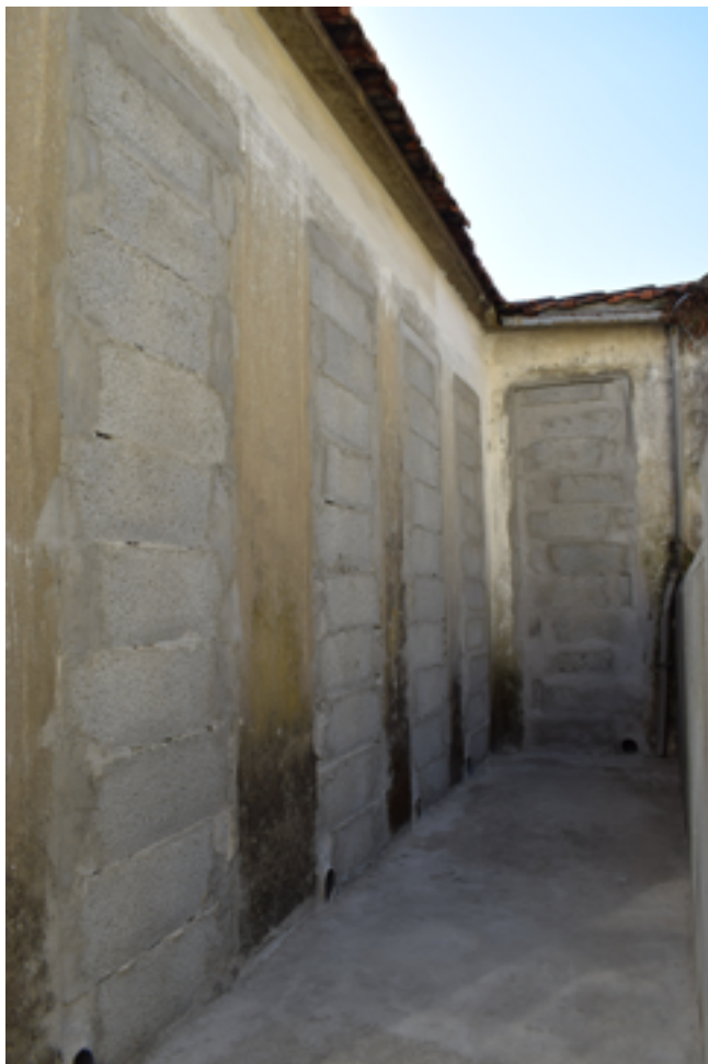
Banheiros coletivos atualmente em desuso.
