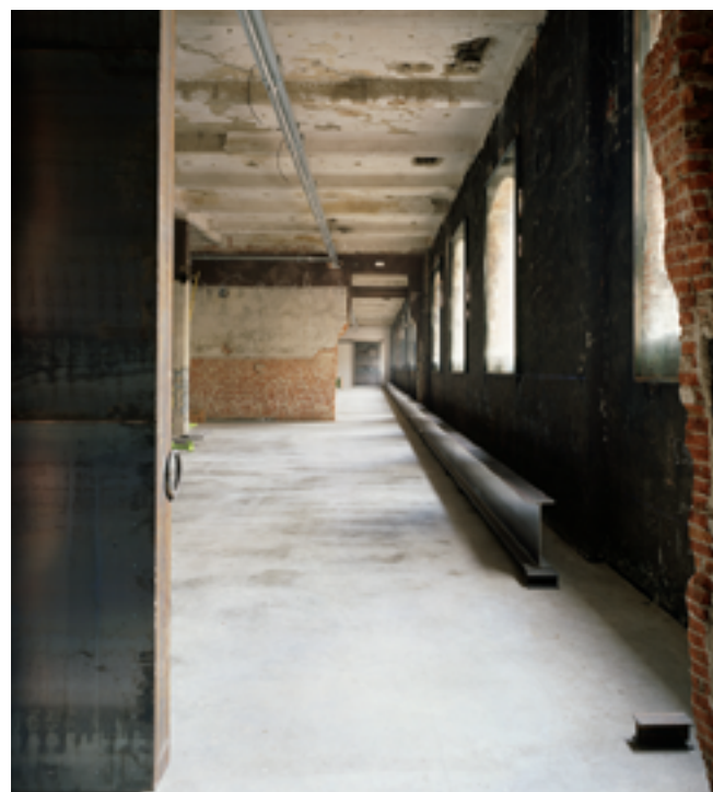
Perfis metálicos HEB-1000 e IPE-600 na forma de mostrador e banco corrido; piso contínuo de concreto armado no vestibulo do Pavilhão 17c - Intermediae.
