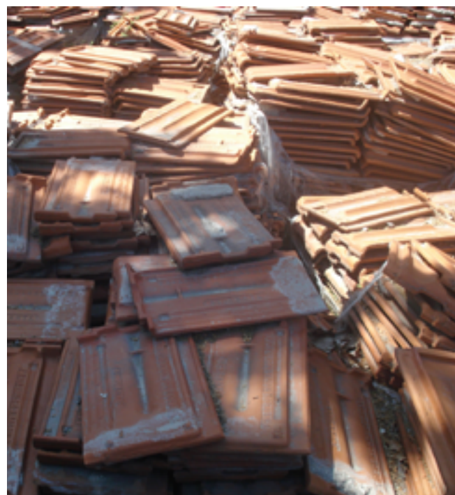
Armazenamento das telhas planas retiradas das coberturas dos galpões do Matadero Madrid.
