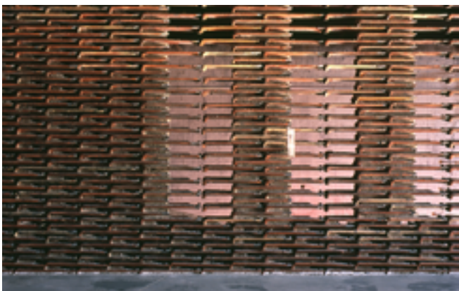
Telhas no Pavilhão 8b - a oficina, depois da intervenção.
