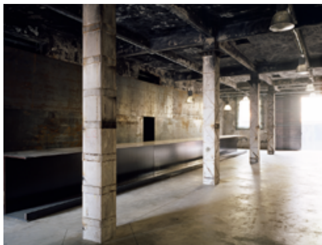
Perfis metálicos HEB-1000 e IPE-600 na forma de mostrador e banco corrido; piso contínuo de concreto armado no vestibulo do Pavilhão 17c - Intermediae.
