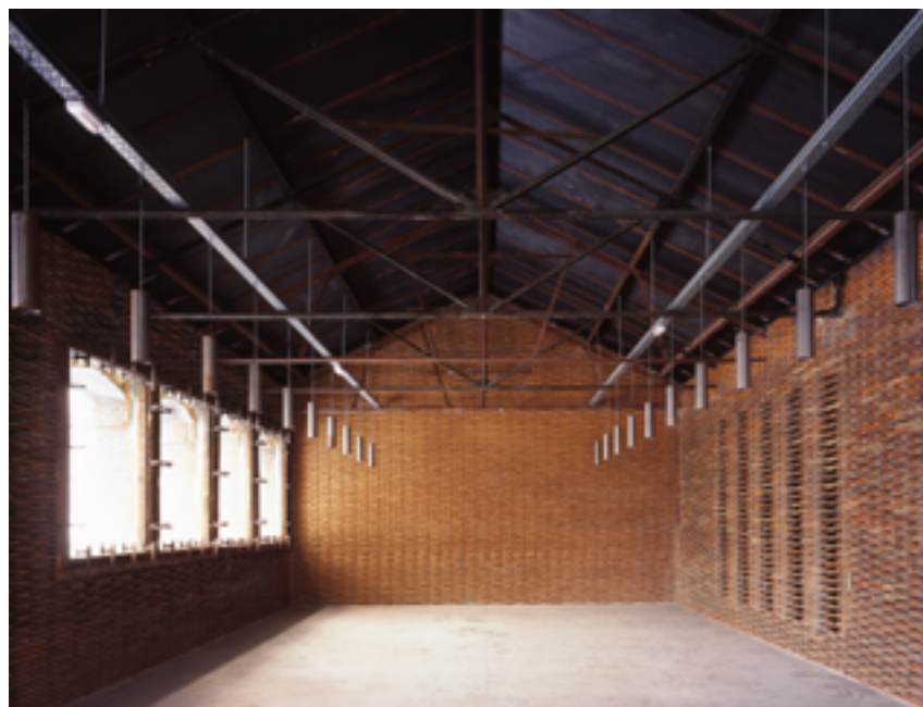
Interior do Pavilhão 8b - a oficina, depois da intervenção.
