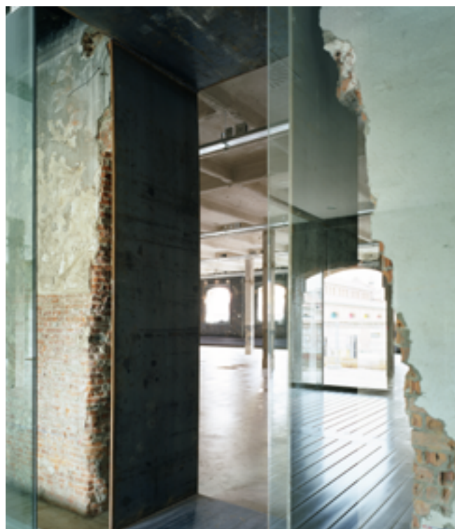
Caixa conformada por perfis de aço e vidro na sala longitudinal do Pavilhão 17c - Intermediae
