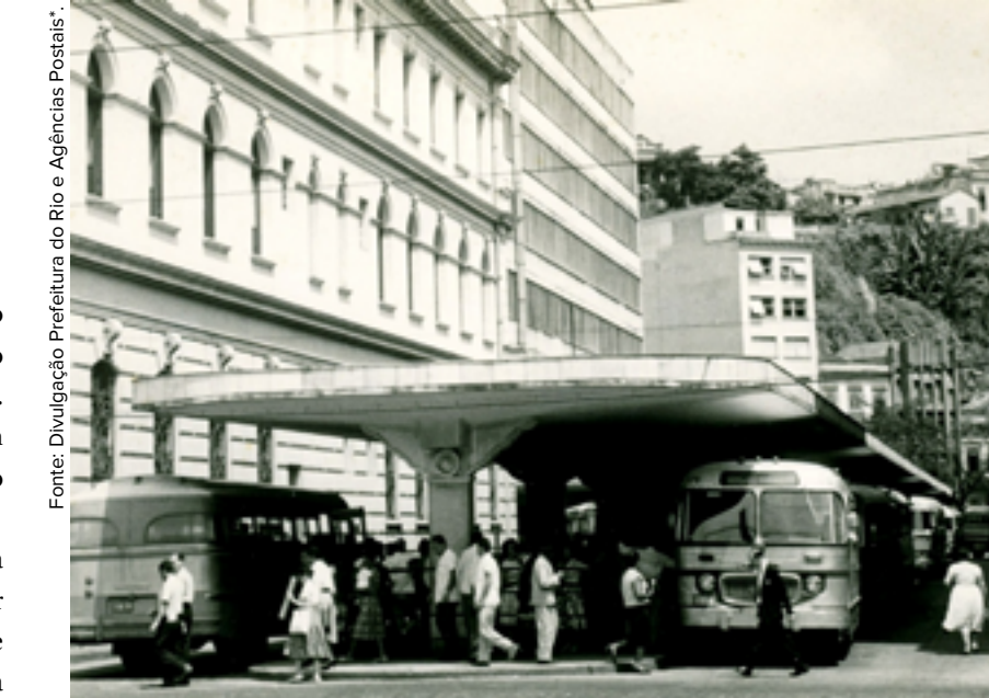
Imagem da condição anterior ao MAR da marquise da rodoviária.
