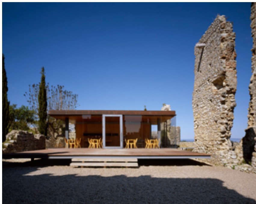
Casa de Chá, Castelo de Montemor-o-Velho.
