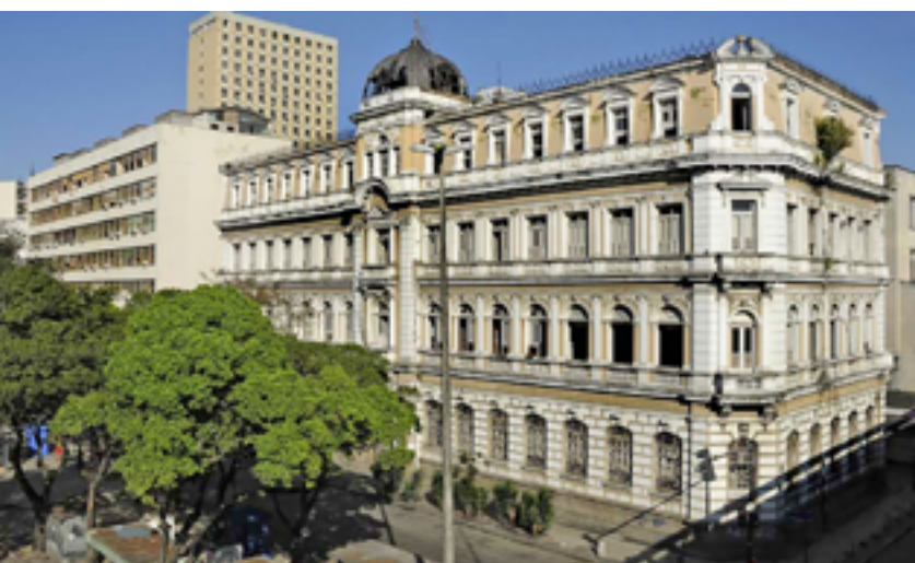
Imagem da condição anterior ao MAR do palacete e do edifício modernista.
