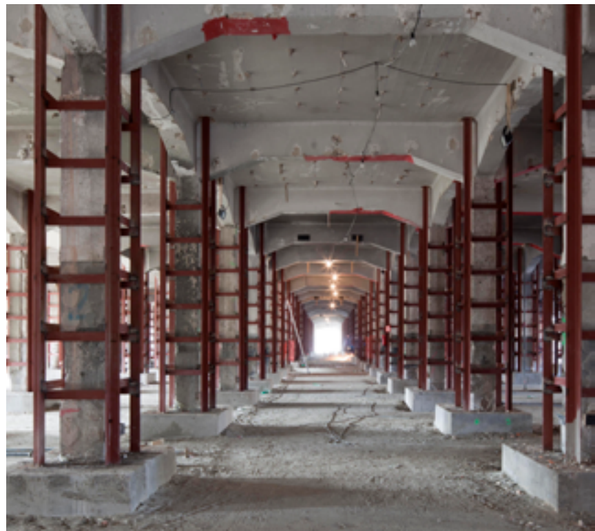
Reforço estrutural nos pavilhões 8 e 9.
