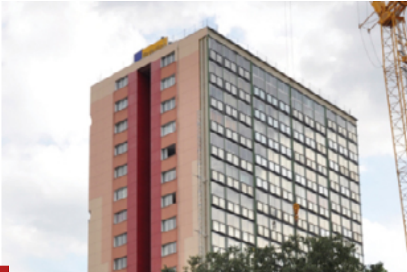
7 e 8. Emprego do concreto armado nas fachadas. 9 e 10. Emprego do concreto armado nas fachadas.
