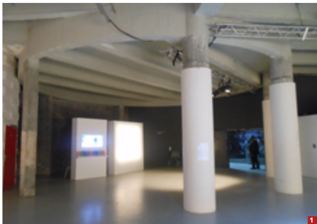
Palais de Tokyo. 1. Colunas engordadas para reforçar a estrutura. 2. Trama metálica para sustentar o revestimento em mármore existente
