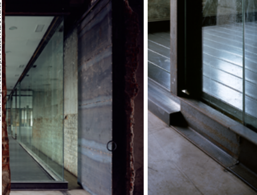
Caixa conformada por perfis de aço e vidro na sala longitudinal do Pavilhão 17c - Intermediae.
