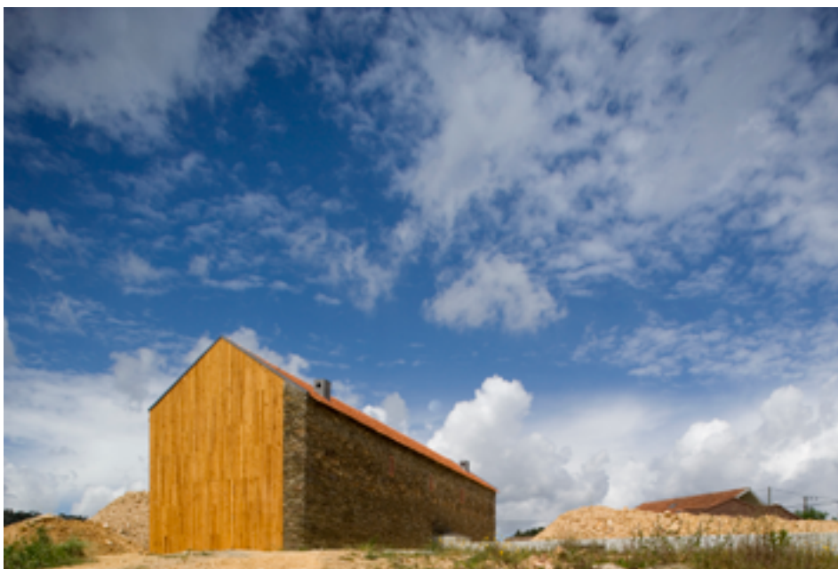
Reconversão de Palheiro, Cortegaça, Mortágua.
