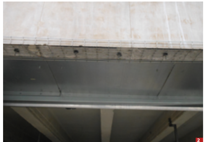
Palais de Tokyo. 1. Colunas engordadas para reforçar a estrutura. 2. Trama metálica para sustentar o revestimento em mármore existente
