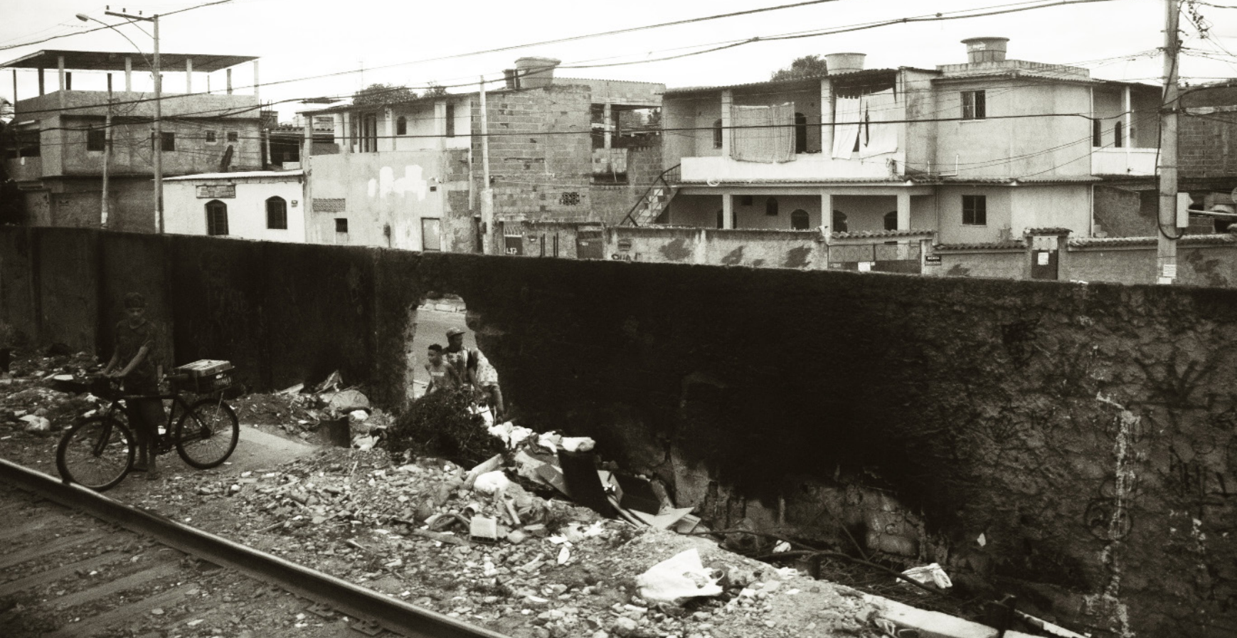
Figura 1. Furo de passagem no ramal ferroviário Santa Cruz, Rio de Janeiro.
