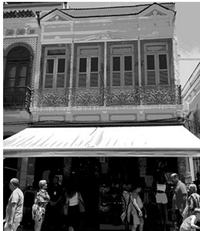
Figura 25. Sobrados na Rua Do Catete, calçada oposta ao Palácio do Catete.
