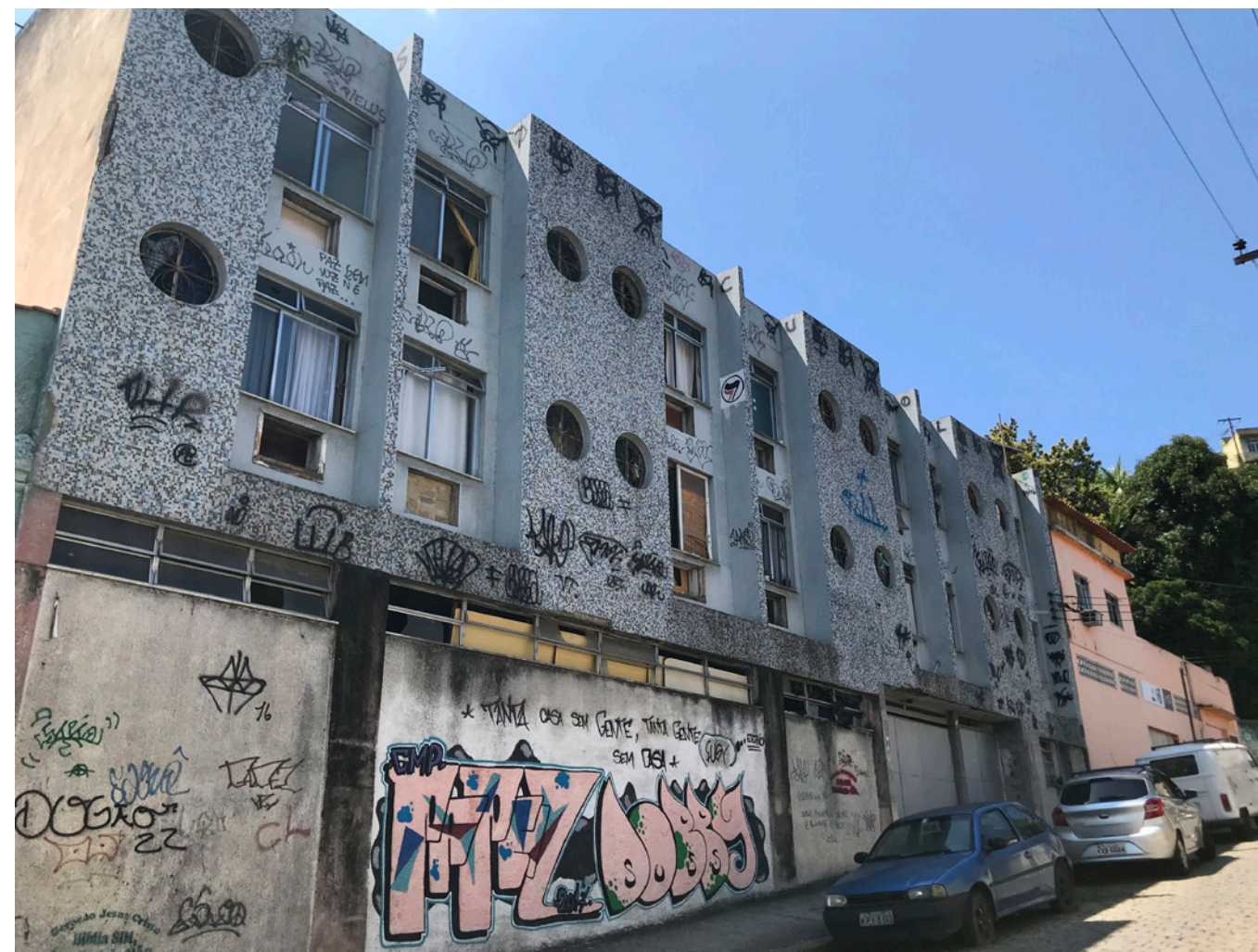
Figura 4. Edifício da Ocupação Vito Giannotti, 2019.
