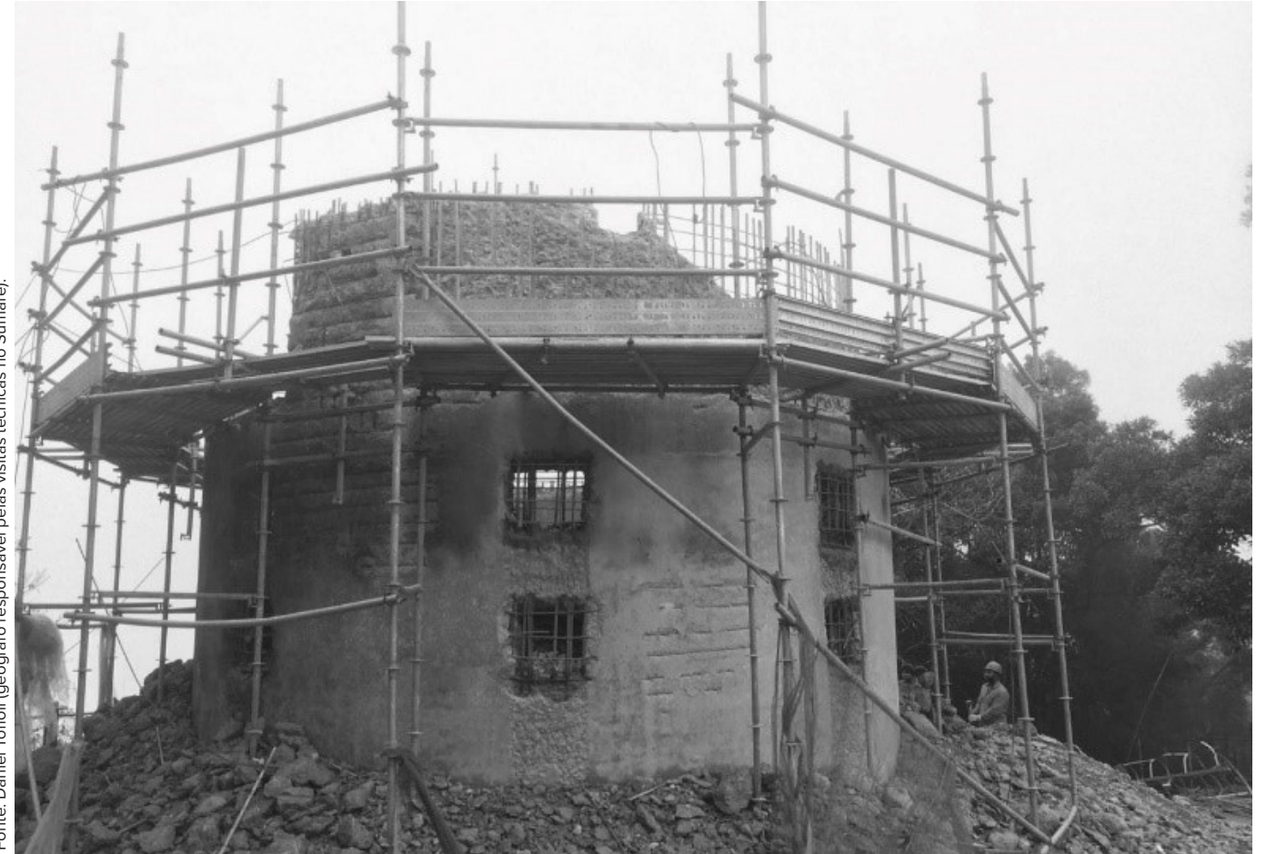
Figura 7. Demolição do corpo da torre durante o processo de arruinamento, 2016.
