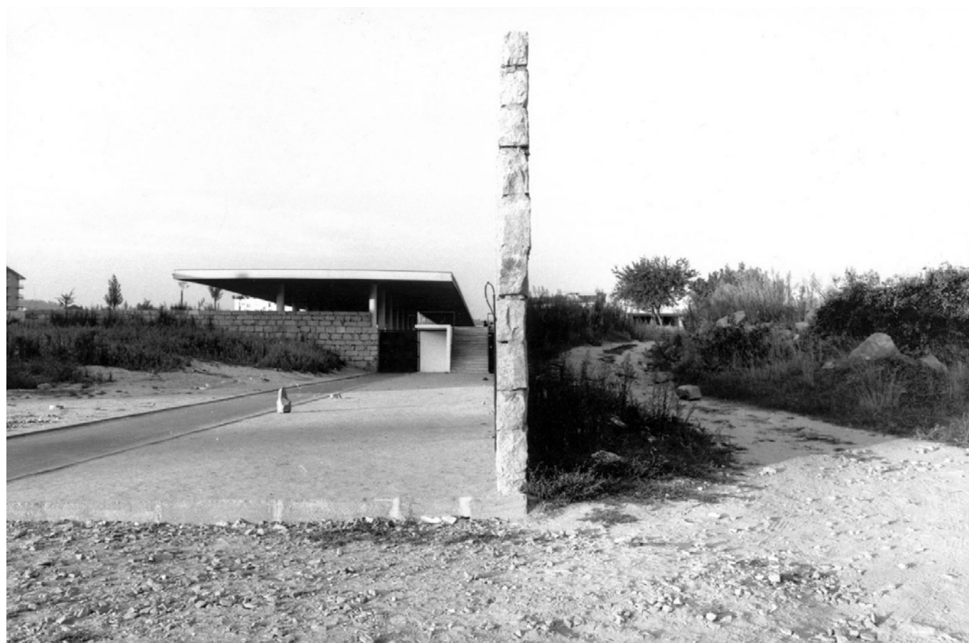
Figura 5. Eixo longitudinal, acesso noroeste. Muro de blocos de granito em junta seca.
