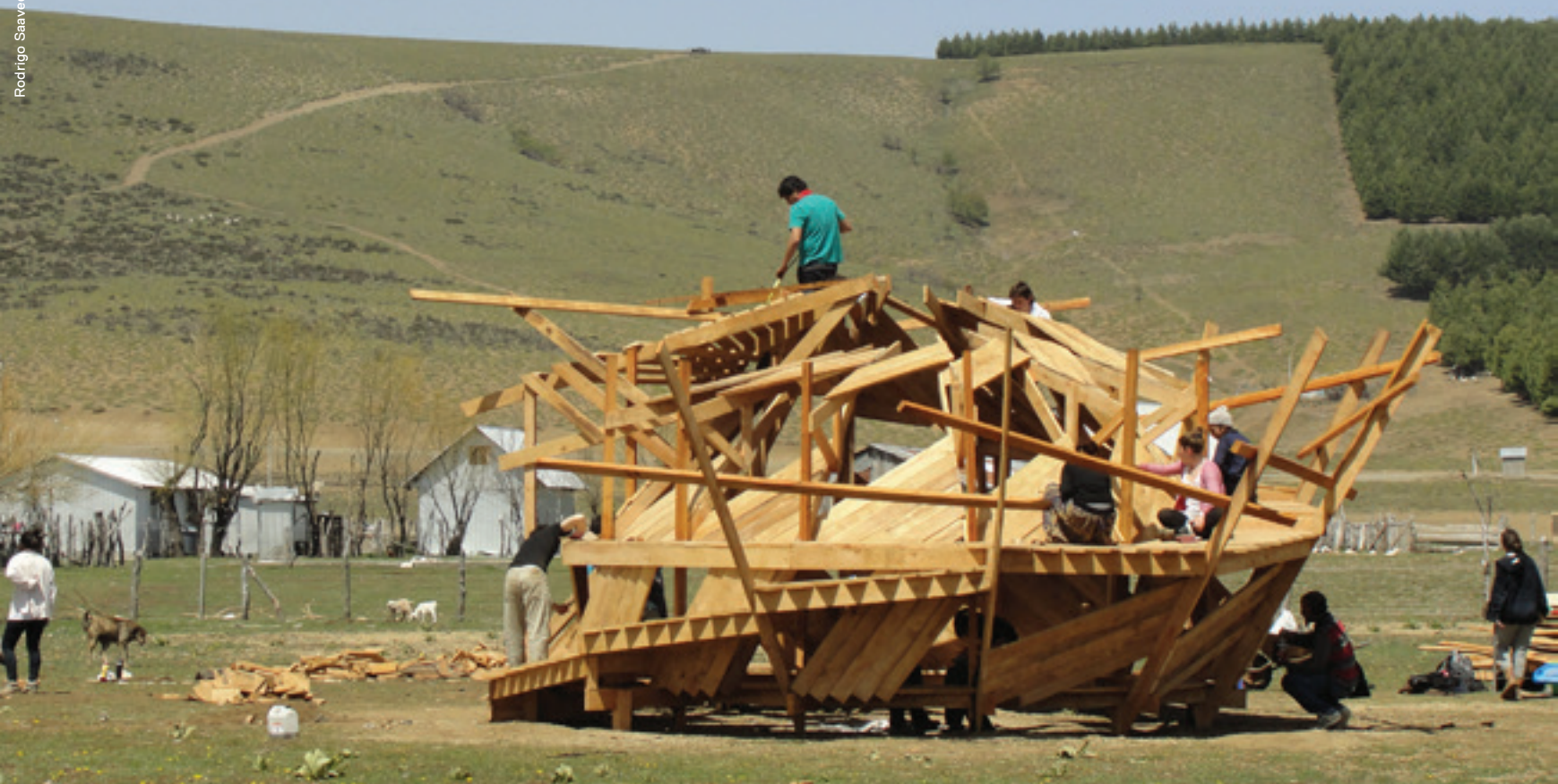
A obra e sua extensão.
