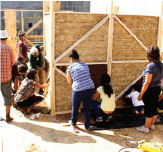
Trabalhos de reconstrução nos morros de Valparaíso utilizando pallets, palha e barro.
