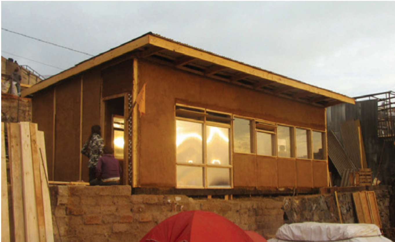
Uma das casas já finalizada.
