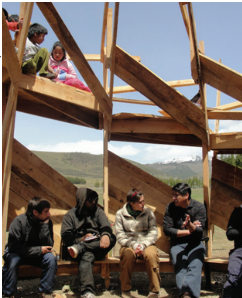
Interior da obra em Marimenuco.
