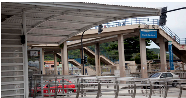
Figura 9: Passarelas para pedestres nas últimas estações construídas.
