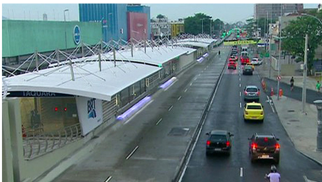
Figura 7: Estação na Transoeste e cruzamento com carros.
