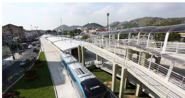
Figura 12: Acesso a uma estação do BRT na Transcarioca.
